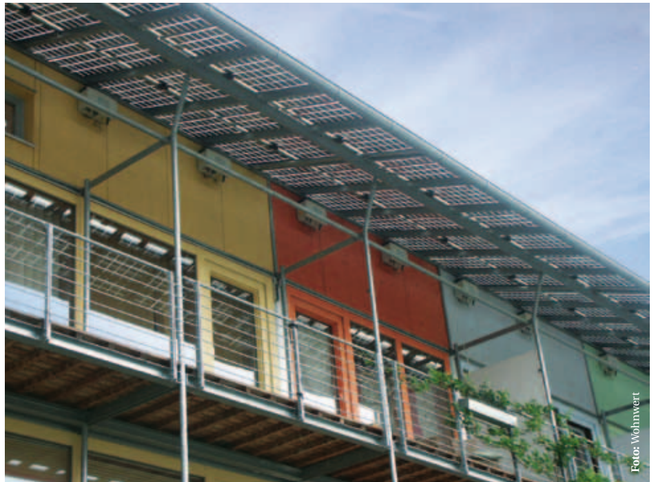
Die Photovoltaik-Technik ist ins Dach integriert
